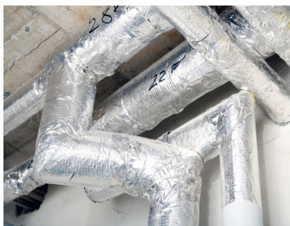
图12: 管道的保温处理
