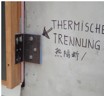
图11: 窗框和外墙之间的热隔断处理
