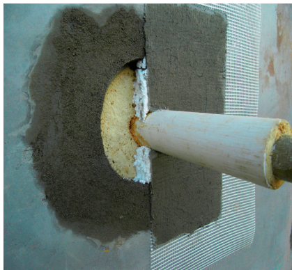
图10: 管道穿透外墙部位的保温和气密处理
