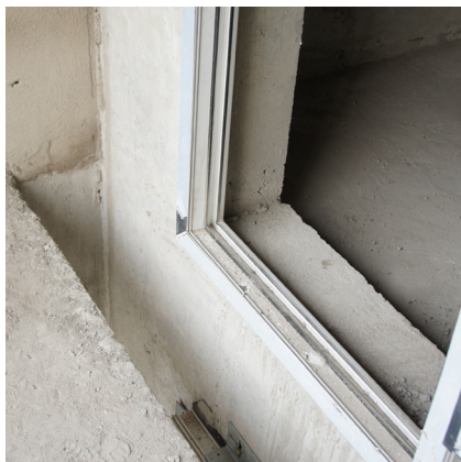
图23：外挑阳台板的热桥最小化处理
