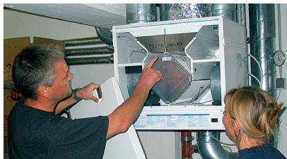
图3: 带热(冷)回收装置的新风系统
