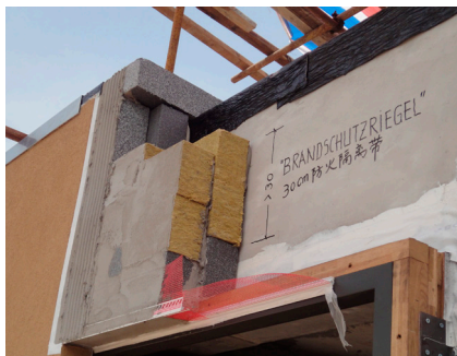
图15: 外保温防火隔离带的施工
