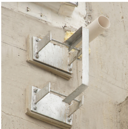
图24：新风室外机支架的断热桥处理
