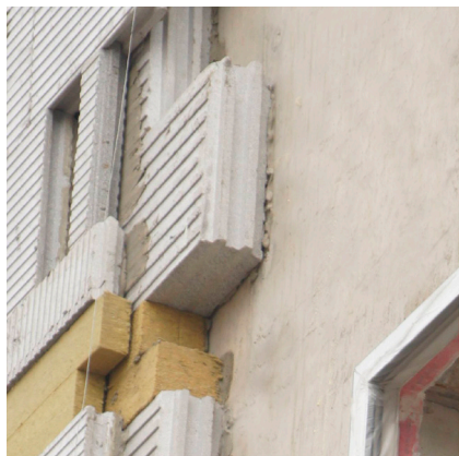
图26：外墙保温及门窗的气密安装
