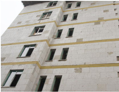
图21：外墙保温中设置环状防火隔离带
