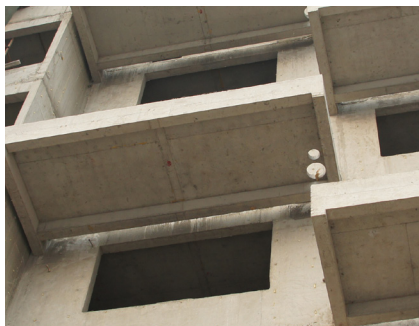
图14: 外挑阳台板的热桥最小化处理
